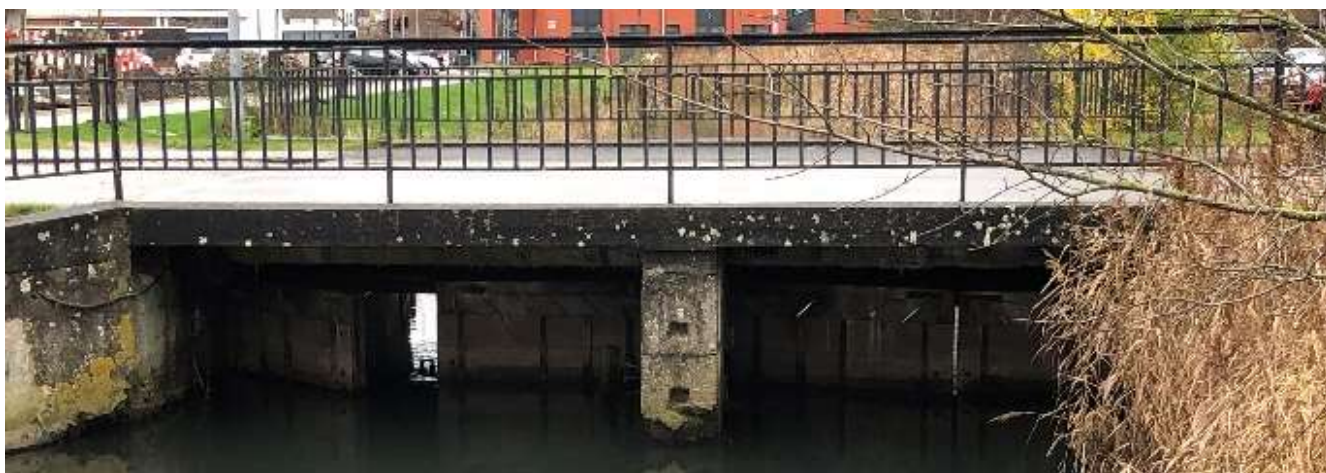
Figur 3.2. Figuren viser den eksisterende sluse, der består af to sektioner.
