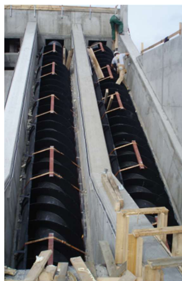
Figur 3.10. Figuren viser Pumpe 2. Foto af åben pumpe. Der etableres efterfølgende overdækning på snegl.
