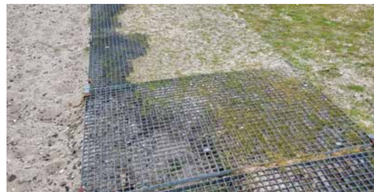
Ved fjordnære områder med krav om tilgængelig adgang kan anvendes gitterriste i galv. stål.
