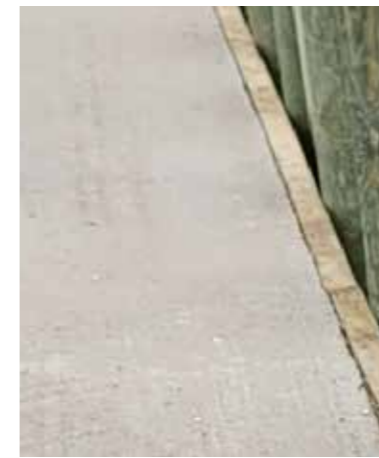
Kantning af betonbelægning i træ. Forskalling bevares.
