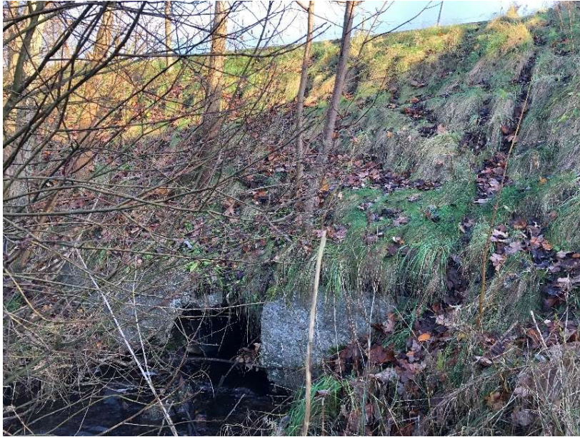
Figur 16: Udløbet fra søen med et fald på ca. 1,3 m ses ved betonbygværket. Søen ligger nogenlunde i niveau med vejen, som kan ses på billedet, og faldet er derfor et lodret fald som udgør en total faunaspærring.
